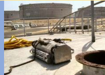
TankRob na dachu zbiornika w rafinerii ropy naftowej w Sines, Portugalia.
